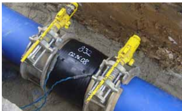
Фиг.: скоби за корекция на кръгла форма за Е- муфи (източник на снимка: +GF+)
